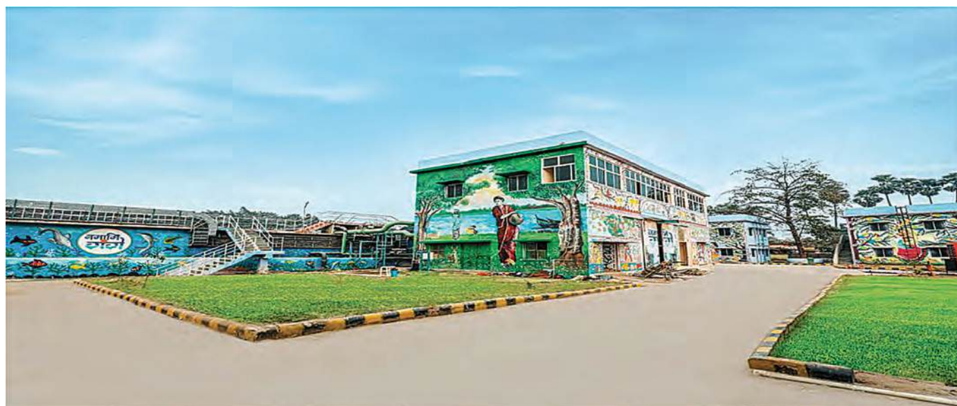
Figure 127 Beur STP 43 MLD
