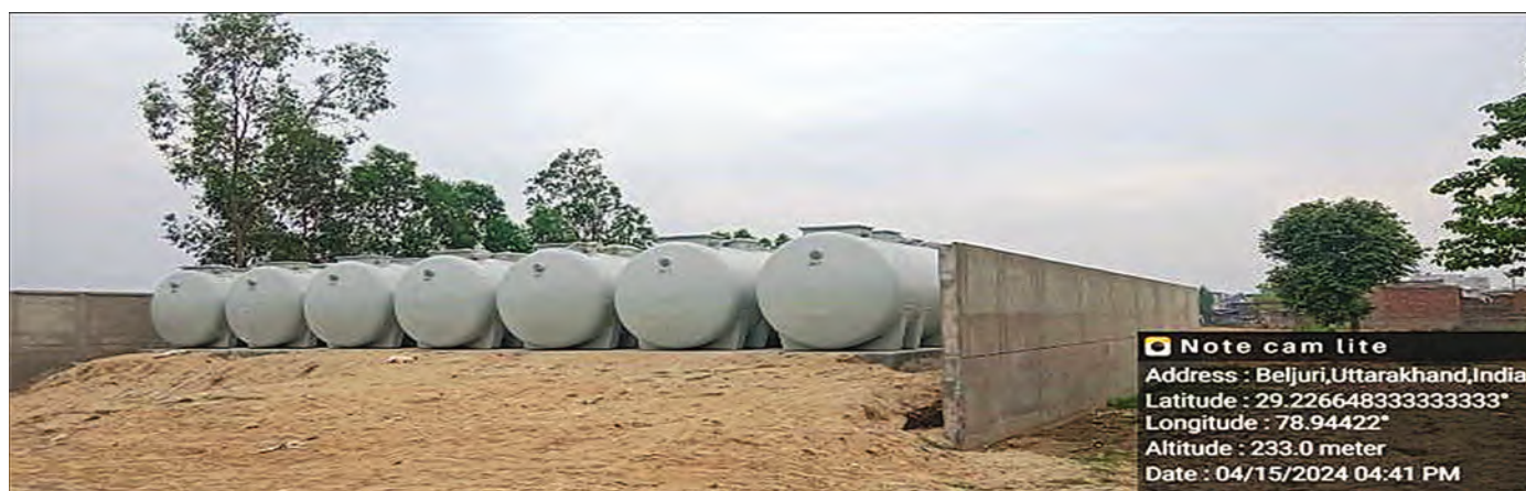
500 KLD STP, Beljuri
